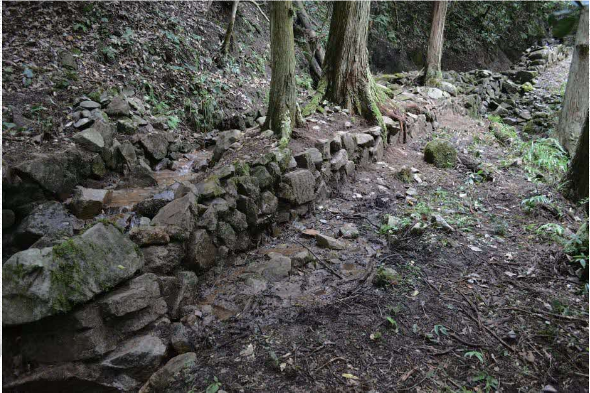
砂鉄を選鉱した水路石垣（砂溜・大池）
