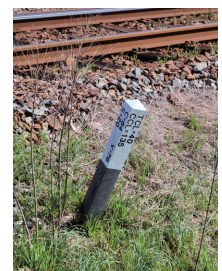
写真 5-2 曲線標 (裏面、R160、O 地点)
