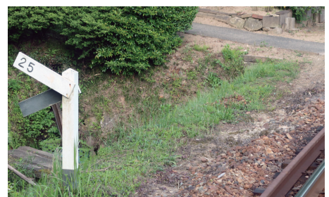
写真 6 こう配標 (南宍道駅東側、25‰)
