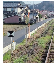
写真 7-2 速度制限解除標識 (左側)
