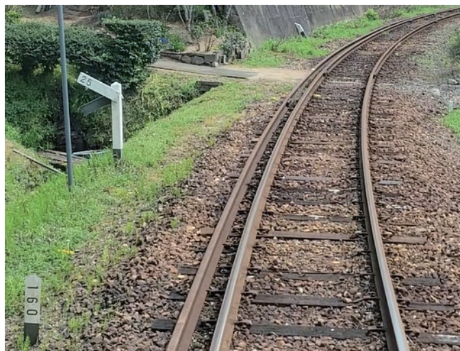
写真1 木次線南宍道駅東側に設置された「曲線標（1号）」（左下、R160）と「こう配標」（左上、25%）
