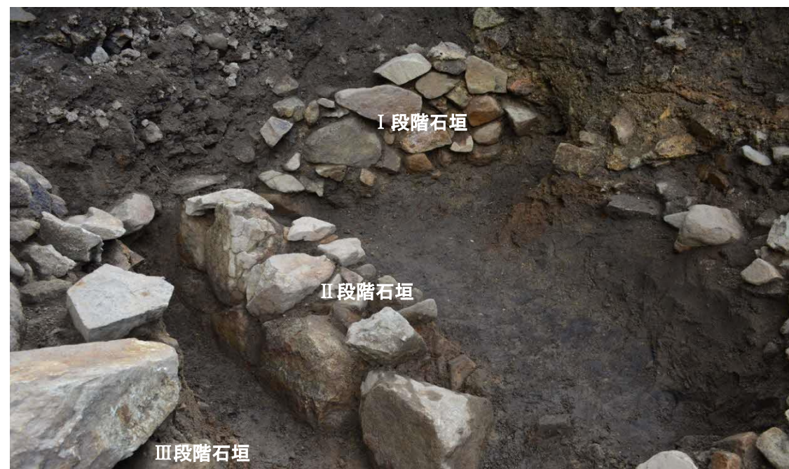
三軒長屋敷地護岸の石垣
