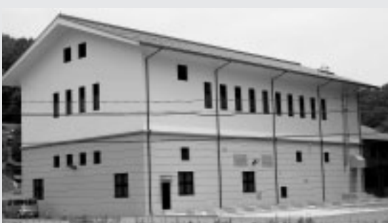
新越戸浄水場（大東町大東）
