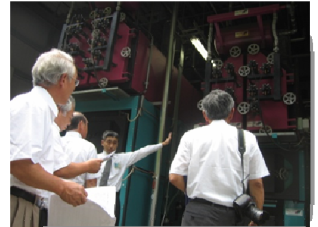
木質チップボイラー
