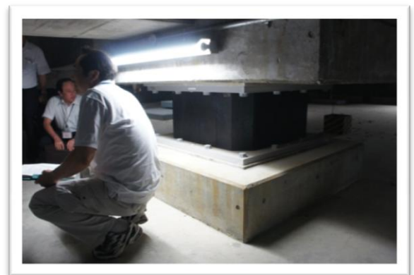
免震構造を採用し災害対応拠点に
