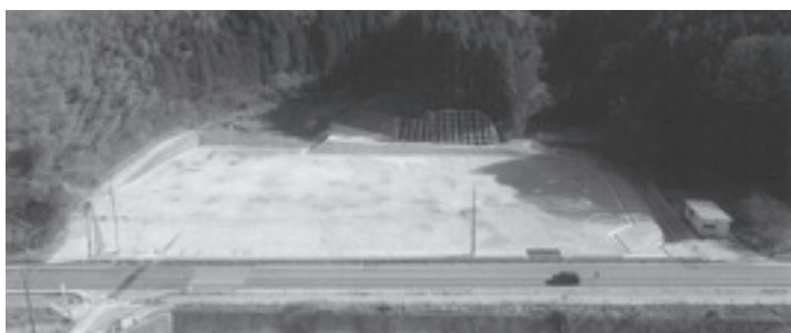
給食センター建設地 (木次町山方)
