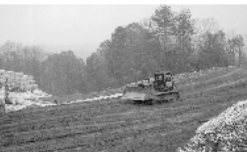
奥出雲バラ園造成工事（三刀屋町）
