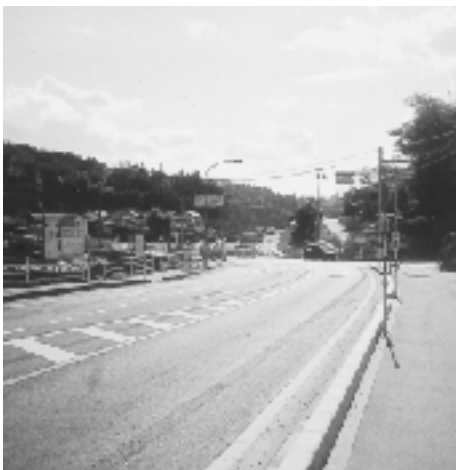
松江木次線バイパス工事 (飯田地区)
