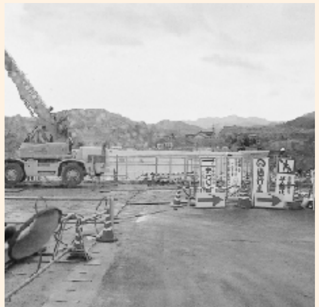
松江木次線バイパス事業(大東阿用川附近現場)
