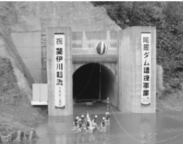
尾原ダム建設に伴う斐伊川転流式
