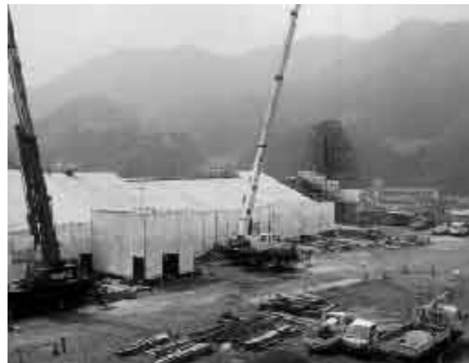
建設の進む掛合統合小学校
