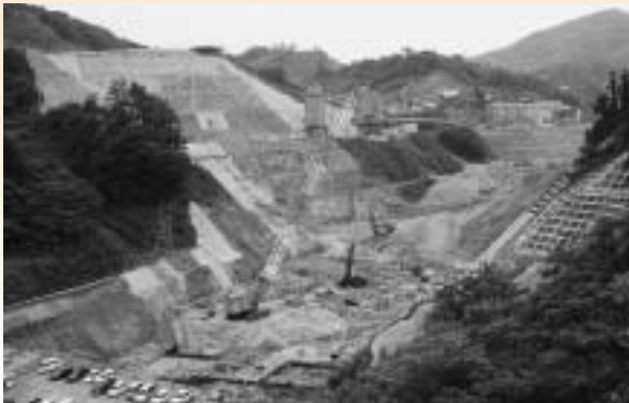
尾原ダム工事現場
