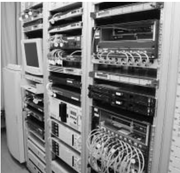
情報通信の中心部分であるヘッドエンド。夢ネット大東局
