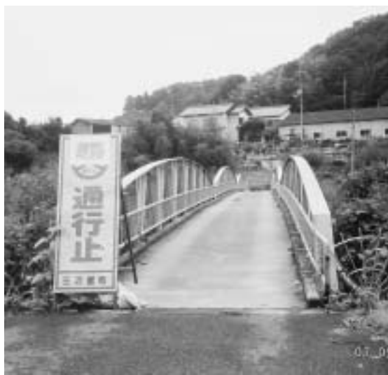
腐食により車の通行が禁止された三刀屋町の畑杭橋
