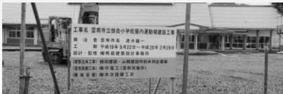
9月議会で契約が承認され、着工した掛合小学校屋内運動場建設工事。契約額は2億1,084万円
