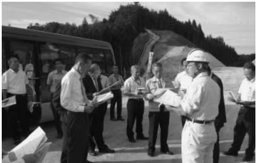
高速道路の工事現場を視察する市議会高速道路対策特別委員会 (10月1日)
