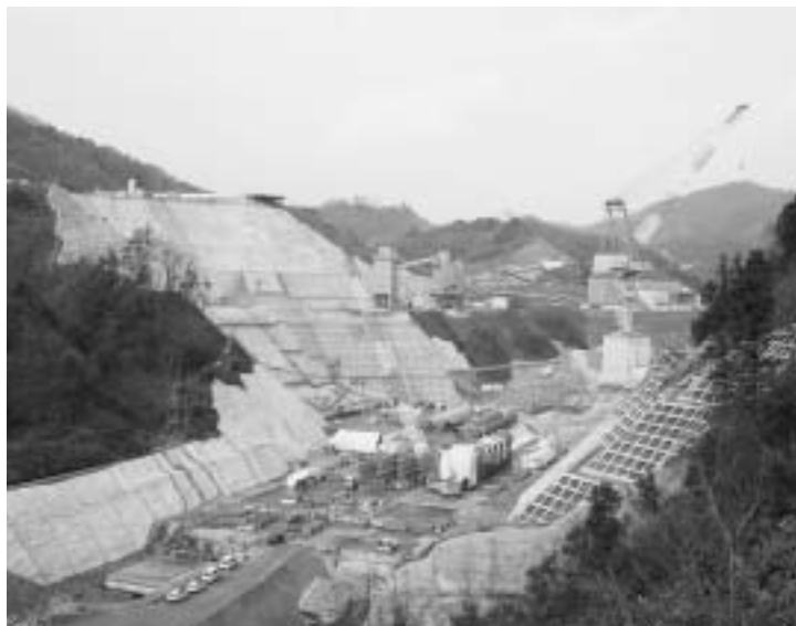
順調に進むダム工事。今後の活性化への取り組みが重要だ。
