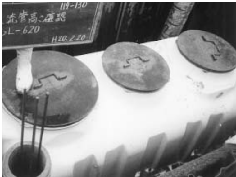
埋設された合併浄化槽
