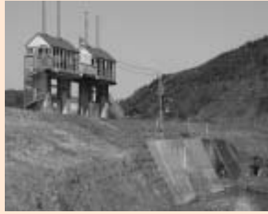
請川の樋門（木次町）
