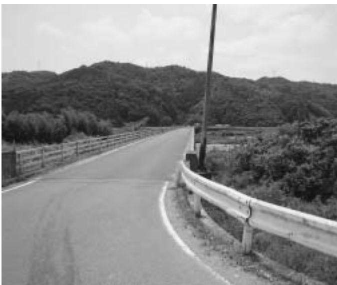
早急に橋の点検、整備を！（三代橋）
