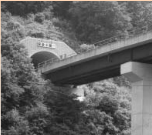
工事が進む吉田インター線
