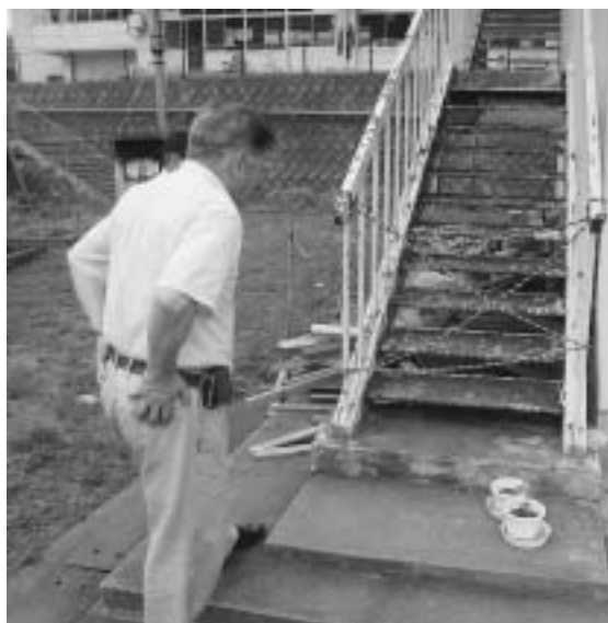
修理が遅れた鍋山小学校非常階段
