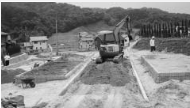
工事が進む市宮下熊谷西墓地
