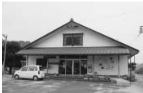
交流センターに向けて改修が必要となる公民館
