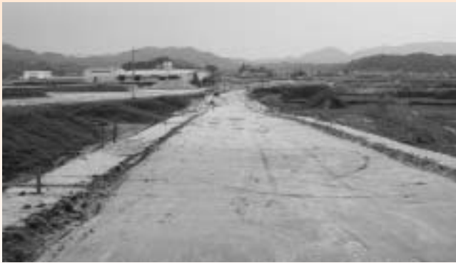
ほ場整備に合わせ改良が進む前原十日市線
