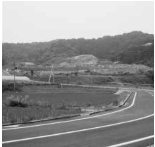
カントリーエレベーターの建設予定地
