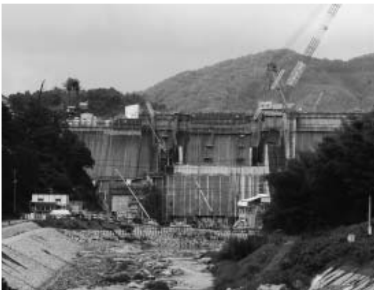
本体工事完成間近の尾原ダム
