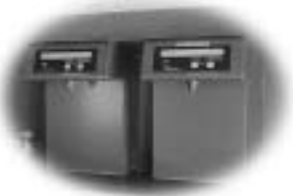
本庁に設置されている自動アルカリイオン水生成装置
