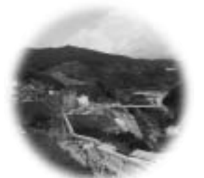
尾原ダムから上流を望む
