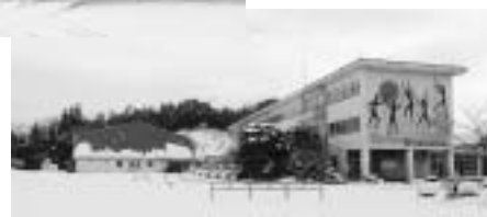
耐震工事が予定される加茂小(左)、大東西小(右)
