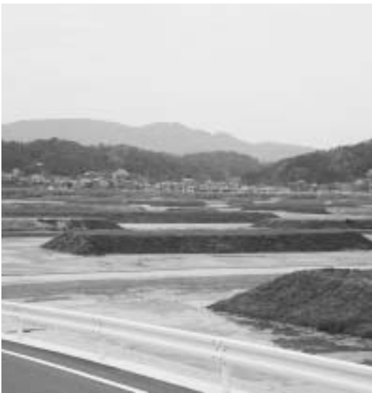
大規模ほ場整備が進む大東町養賀原
