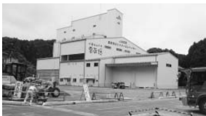
完成間近の雲南市カントリーエレベーター
