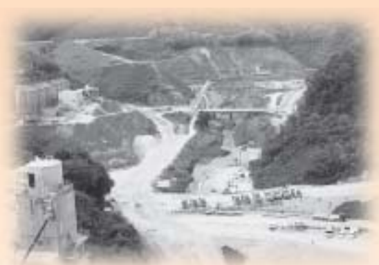
堤頂から北原方面を望む
