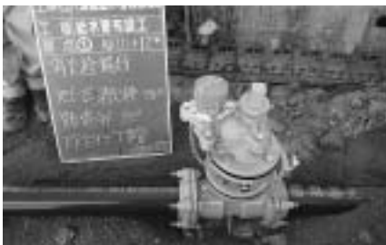
計画的な整備が望まれる消火栓
