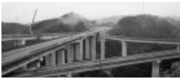
工事が進む尾道松江線(広島県)
