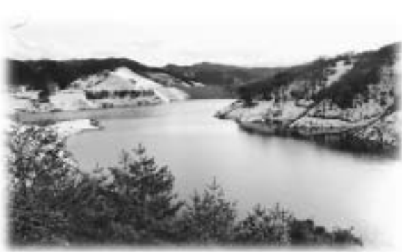
試験湛水の状況 (平成23年1月11日現在)
