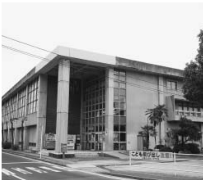
老朽化が進む体育館
