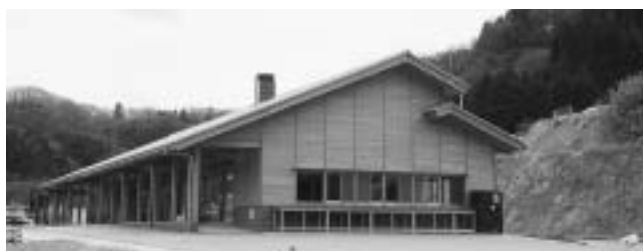
オープン近し「尾原ダム道の駅（おろちの里）」
