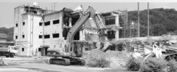
解体が進む三刀屋中学校
