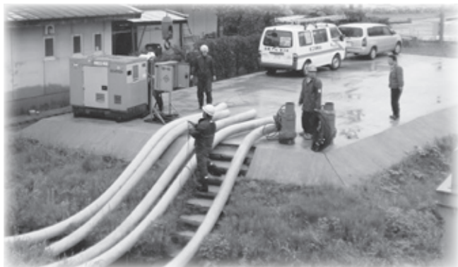
排水ポンプ設置作業（三谷川）
