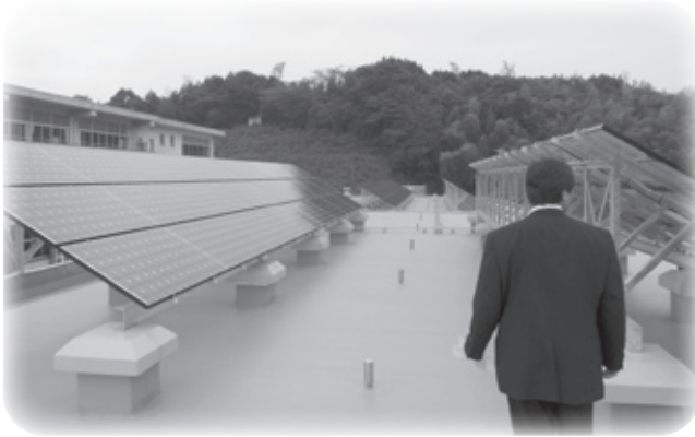
西小学校の太陽光発電施設
