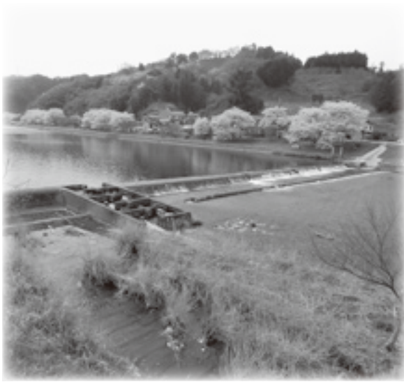
改修がまれる天神頭首工
