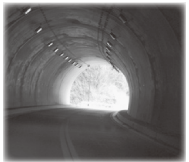
点検巡回で維持管理がより重要となったトンネル
