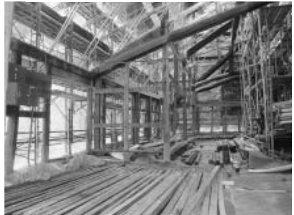
全解体になった高殿内部
