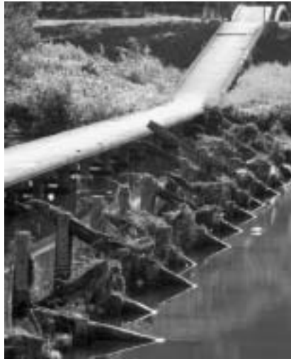
改修が決定した潜水橋
