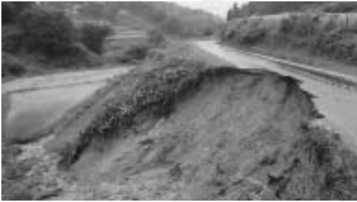
豪雨により崩壊した農道(吉田上山地区内)
