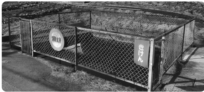
早急に地下式に整備が求められる防火水槽
