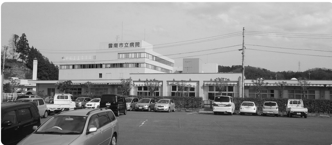
雲南市立病院建設予定地
