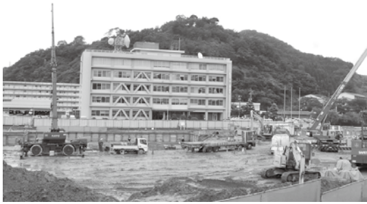
着々と建設が進む新庁舎
