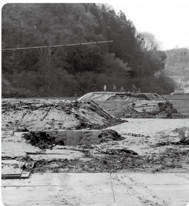
工事が進む南加茂のほ場整備
