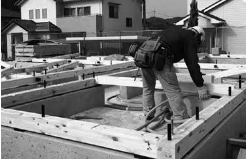
新築中の住宅
