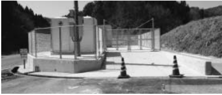
大東町須賀ポンプ場
