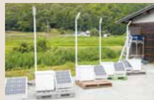
▲炭を使った蓄電池を活用した街灯システム
