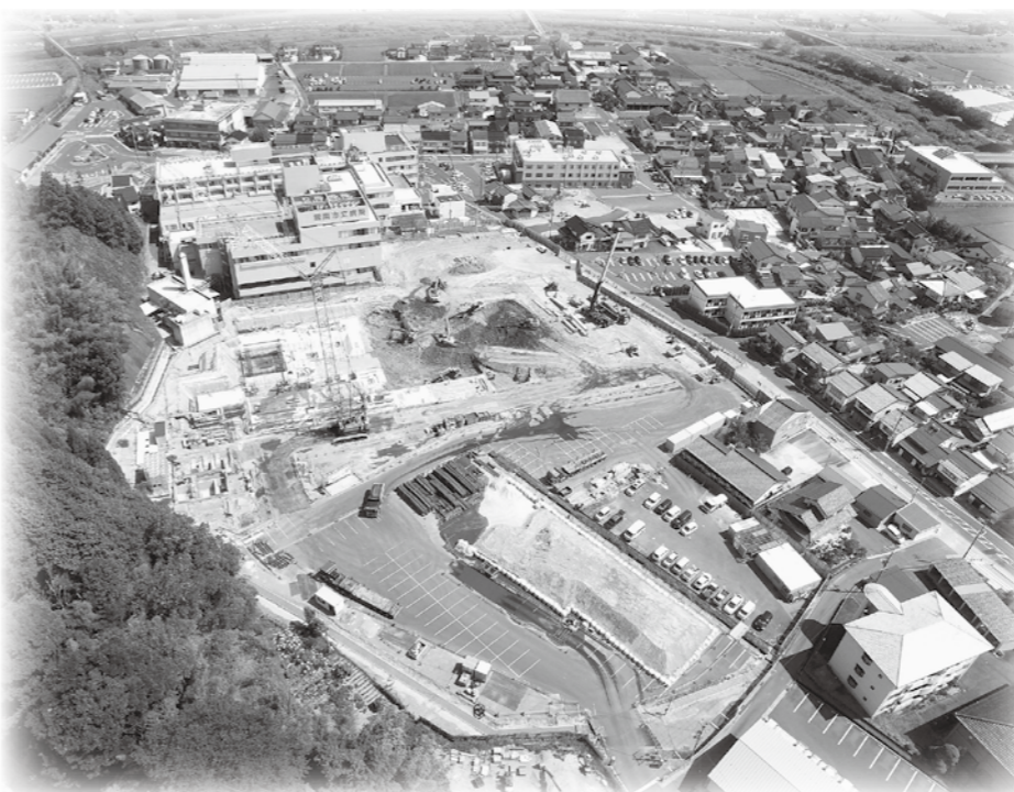
▲病院南側から撮影した建設現場の状況（7月23日撮影）
