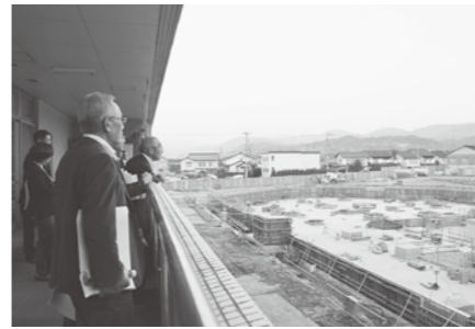
▲新本館棟建設現場を視察
