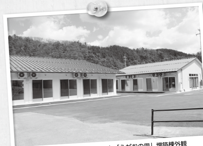
雲南市立特別養護老人ホーム「えがおの里」増築棟外観
