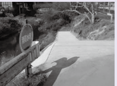
石防火水利整備事業 消防水利用進入路整備の状況
