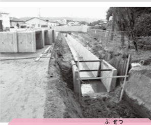
2016.02.03 水路布設状況
