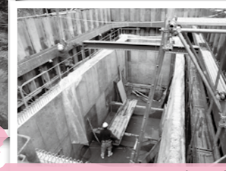
2016.01.30 オイルタンク壁設置状況
