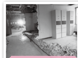
2015.11.09 壁の撤去状況
