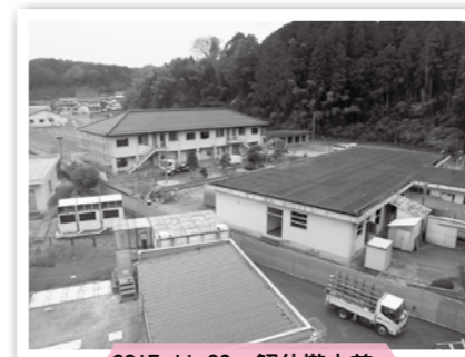
2015.11.09 解体撤去前 （庭木の処理）
