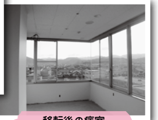
移転後の病室
