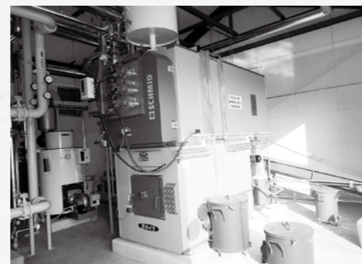
木質チップボイラー
