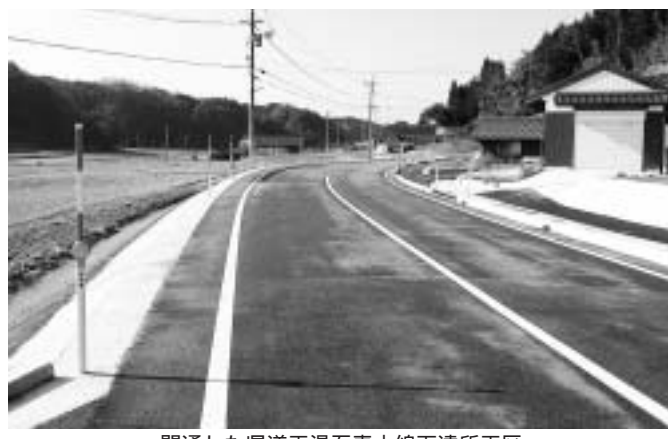
開通した県道玉湯吾妻山線下遠所工区
