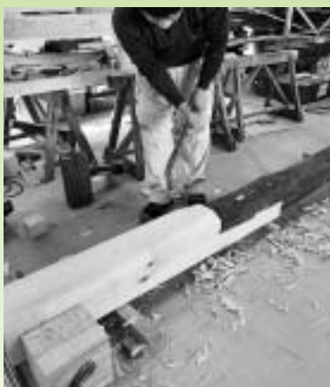
■大工による部材の繕い
