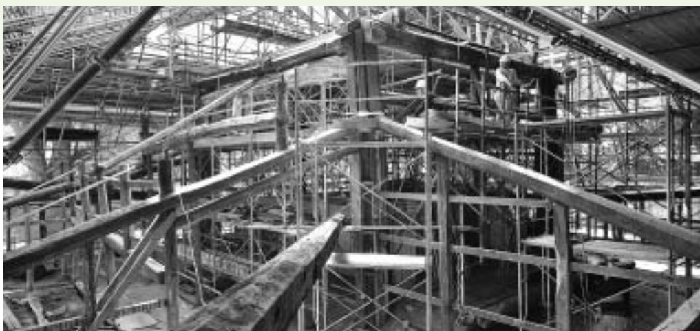
■解体中の高殿
