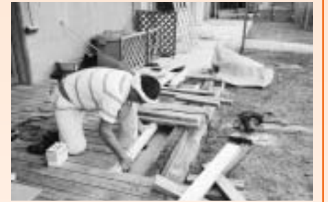
ウッドデッキも修理していただきました
