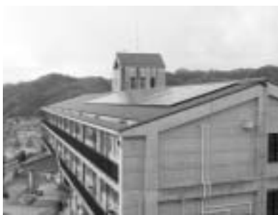
寺領小学校の屋上に取り付けられた太陽光発電用パネル
