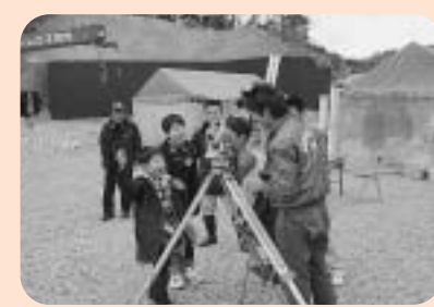
吉田掛合インターチェンジ工事現場も見学会場に。
