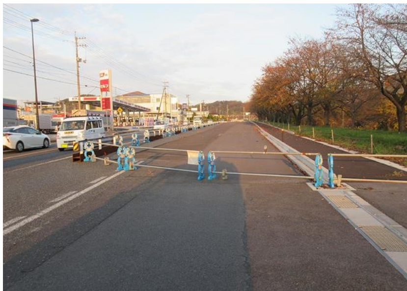
国道54号里方歩行者自転車道整備事業 現況（整備中）
