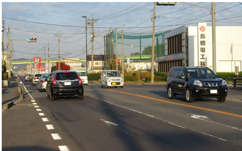
国道54号三刀屋幅4車線区間 現況（未整備）
