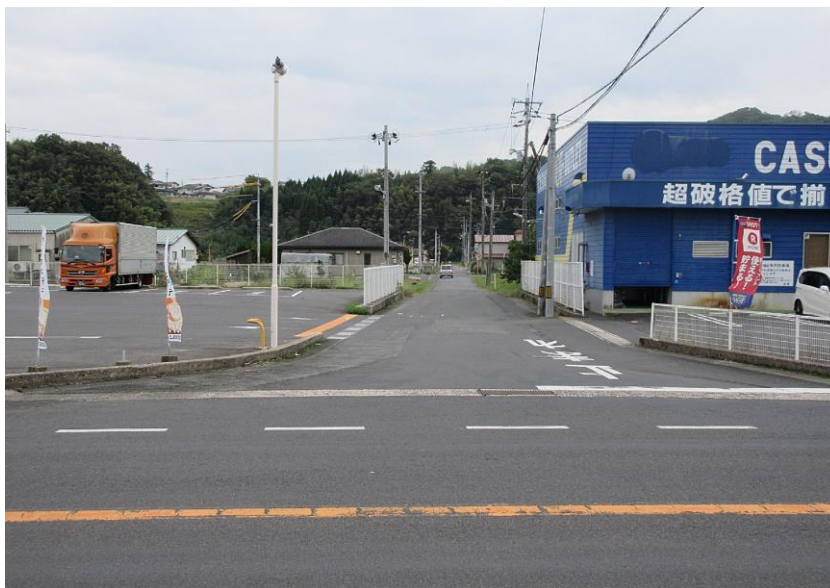
市道基町住宅線 現況
