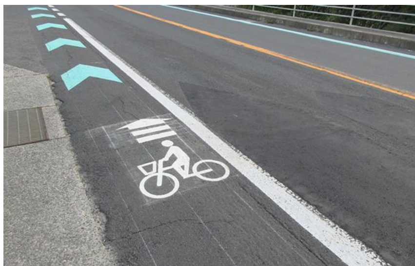
やまなみ街道サイクリングロード 現況（整備済み箇所）
