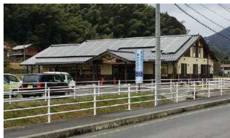
近隣施設の屋根を借りた 太陽光発電パネル
