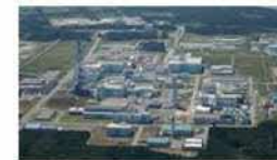
再処理工場 2024年度上期竣工目標
