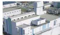
高レベル放射性廃棄物 貯蔵管理センター 1995年操業開始
