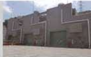
ガスタービン発電機
