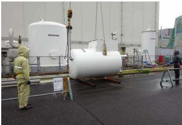
放射線管理区域外にある役目を終えた設備の解体撤去 (窒素ガス制御系設備の撤去【完了】)
