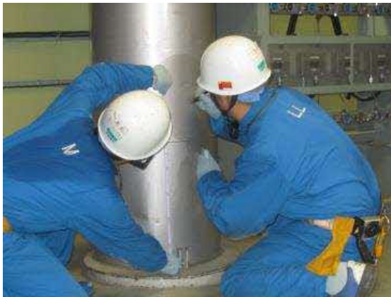
汚染状況の調査 (線量率測定箇所のマーキング【完了】、 現在、データ取りまとめ中)
