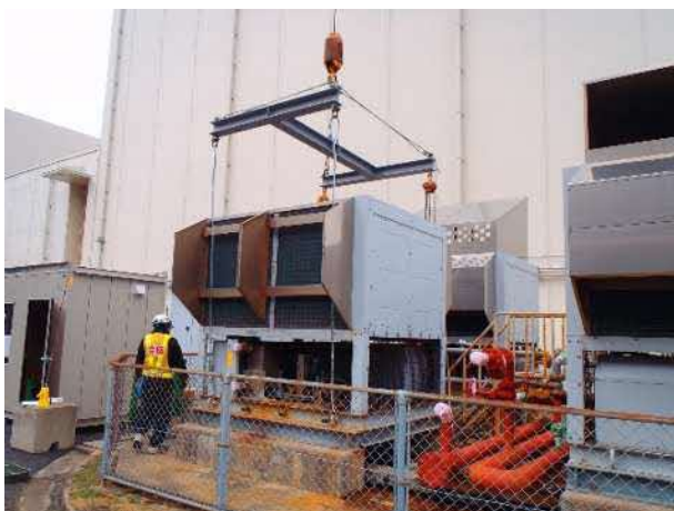
放射線管理区域外にある役目を終えた設備の解体撤去 (原子炉建物空気冷却系冷凍機の撤去【完了】)
