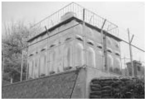
大東北部水道未普及地域解消事業 山田配水池
