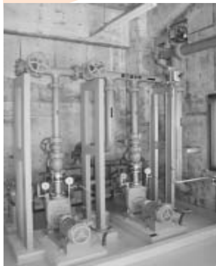
膜ろ過ポンプ
