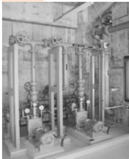
膜ろ過ポンプ
