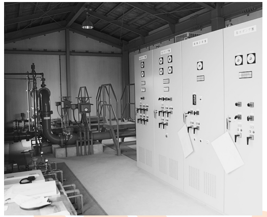
新設された揚水機内部
