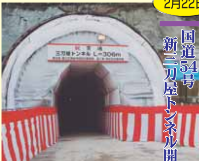
三刀屋トンネルは、山陰と山陽を結ぶ大動脈として、日当たり15,900台の交通量があります。
